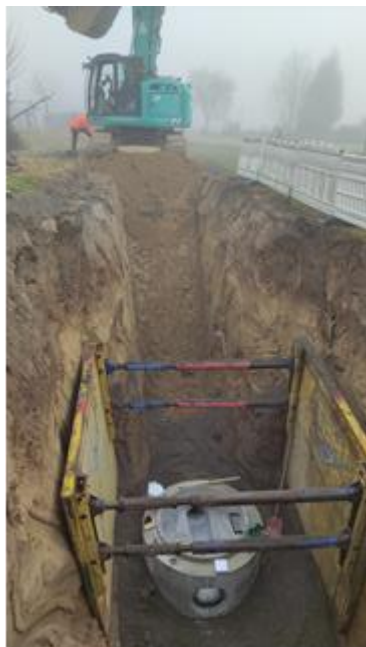
Durchpressung K-Straße DN 300 Kanal
