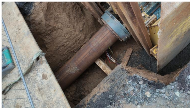
Durchpressung K-Straße DN 300 Kanal
