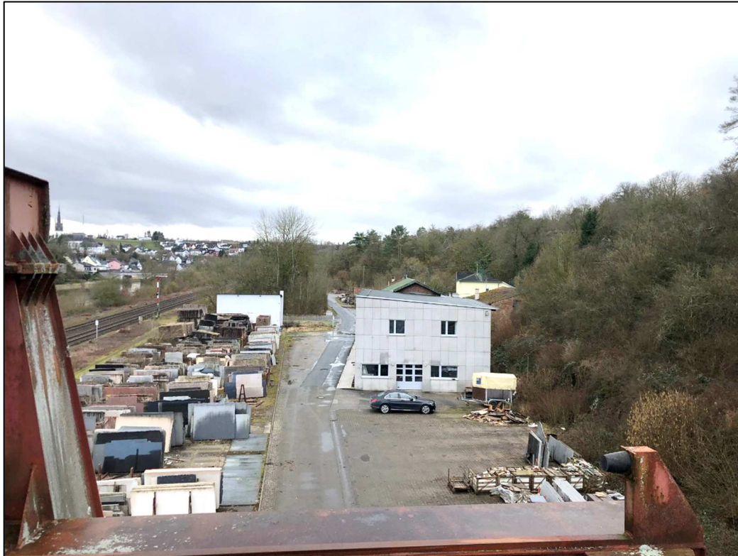
Abb. 10: Blick von der Schwerlastkrananlage in südliche Richtung, über die Betriebsanlage (Erschließungsstraße nebst Natursteinlager und ehem. Verwaltungsgebäude). Links im Bild: der Bahnkörper, die Lahn und die Ortslage von Villmar (Quelle: Micon-Verwaltungs GmbH, 25.02.2020)
