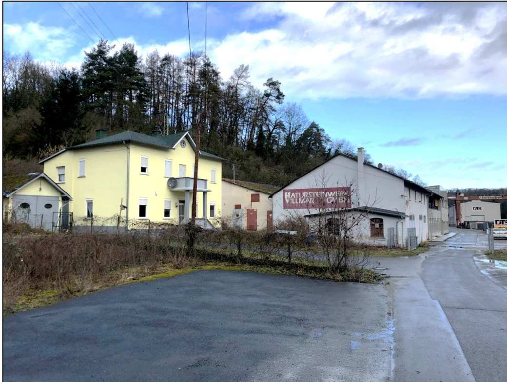
Abb. 4: Blick auf den südlichen Gebäudebestand des Betriebswohngebäudes und des ehemaligen Verwaltungstraktes (Quelle: Micon-Verwaltungs GmbH, 25.02.2020)
