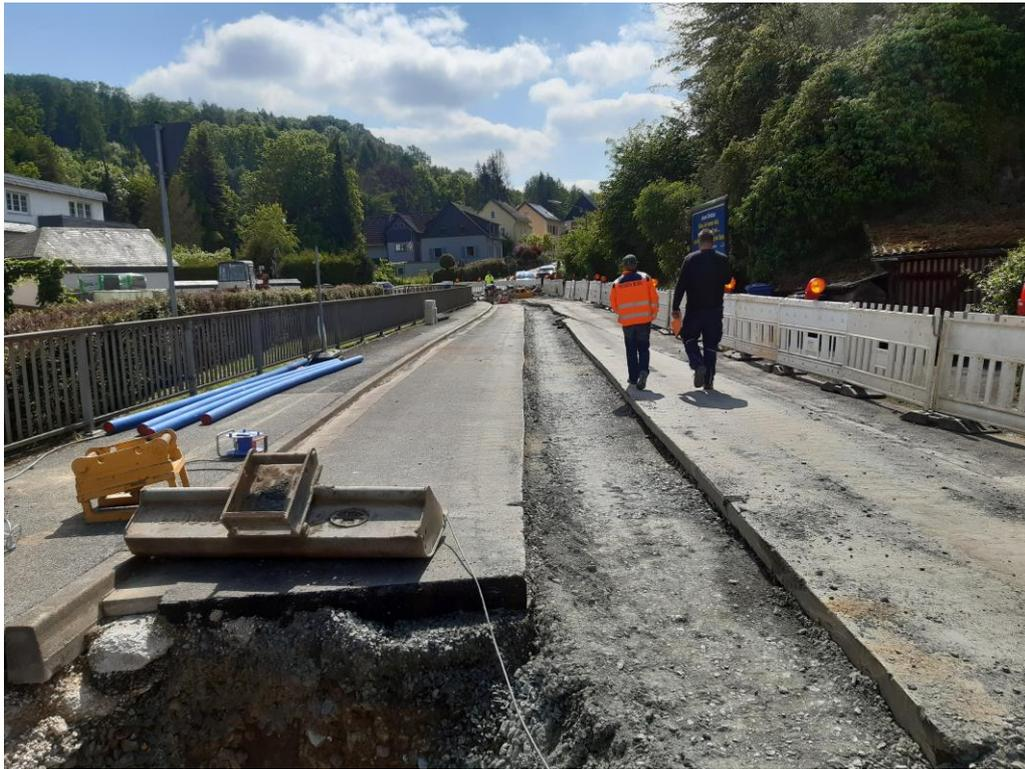
Bei diesem Abschnitt wird die Decke von Hessen Mobil komplett gefräst und mit einer Deckschicht saniert. Die Gemeinde übernimmt die Kosten der Trinkwasserleitungsgrabenoberfläche.
