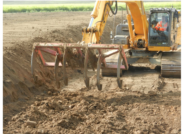
Lockerung des Planums vor Bodenauftrag mit Tiefengrubber. Ein Wechsel zwischen Baggerlöffel und Tiefengrubber ist mittels Schnellkupplung leicht möglich. © Gerhard Dumbeck
